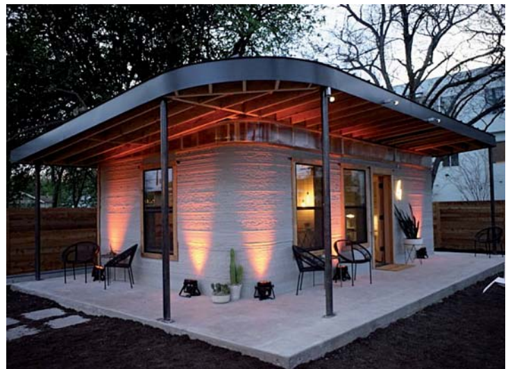
Printana betonska kuća; Izvor fotografije: https://www.fabbaloo.com/news/3d-printing-concrete
